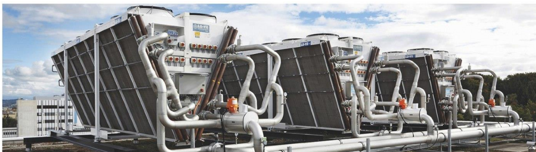
Raffreddatori di liquido per freecooling con sistema spray.
