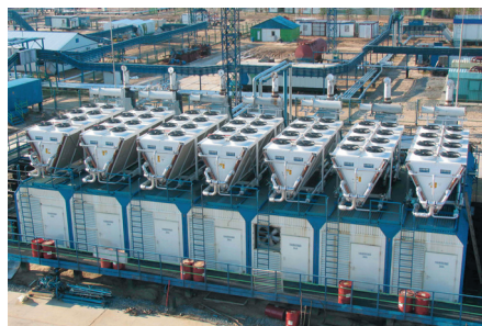
Рис. 2. Система охлаждения газопоршневых энергоустановок
