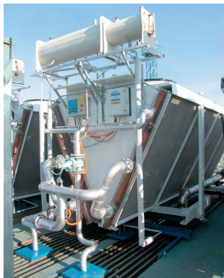
Рис. 1. Специальный четырех-контурный охладитель жидкости
